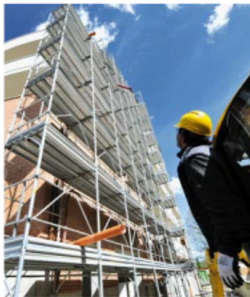
Un cantiere edile
